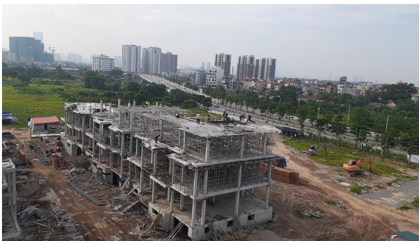
Hoạt động xây dựng hạ tầng đô thị tại Hà Nội
